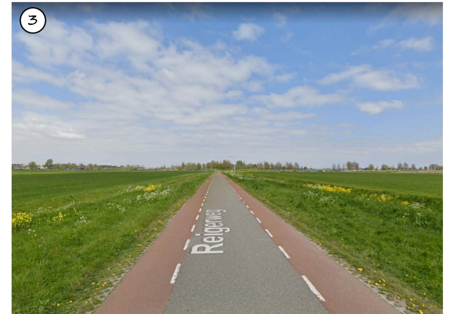
Figuur 3: Profiel nieuwe ontsluitingsweg, asfalt met suggestiestroken
