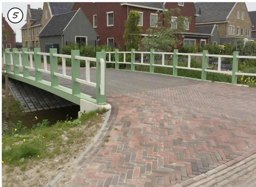
Figuur 7: Onderscheid in materiaal tussen overbrugging en Opmeerder Wuiver
